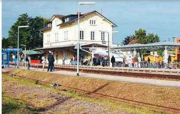
Auch im Bahnhof Kandel in der Pfalz gibt es einen ebenerdigen Bahnübergang (links), dieser wird durch ein Schiebetor gesichert. Bild: BÖCKER
