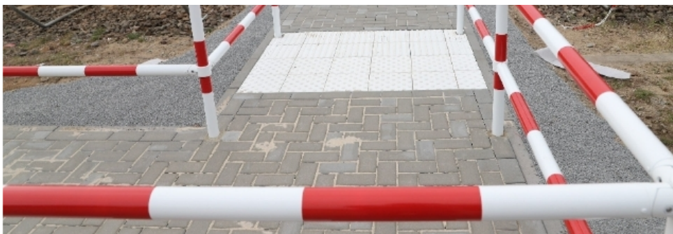
Umlaufsperrung: Anstelle der abgerissenen Fußgängerbrücke ist ein neuer Bahnübergang in Schwedt im Bau. © Foto: Michael Dietrich/MOZ
